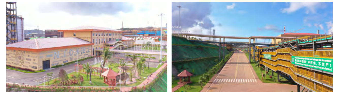
가든식 공장 건설
